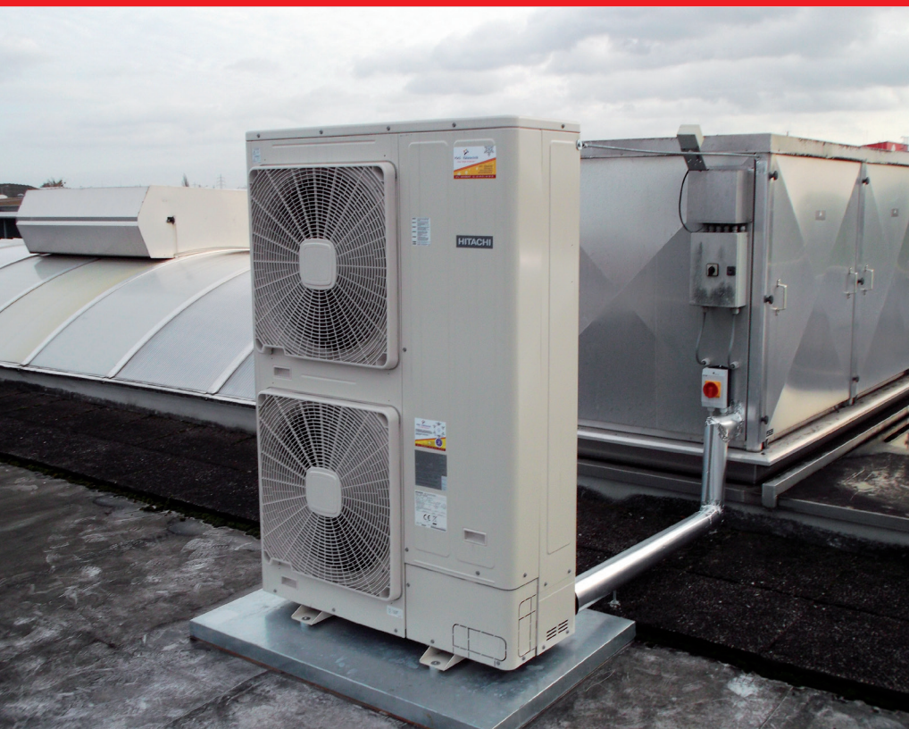
Platzsparende Dachaufstellung der Außeneinheit
